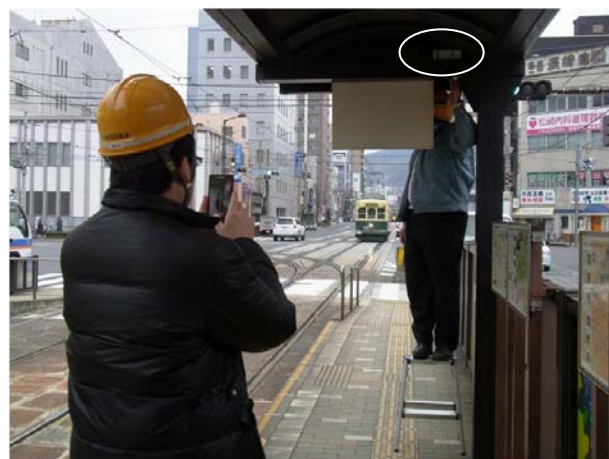
＜図 6: 電停への Bluetooth 発信機(白丸)設置・テスト風景＞
